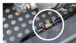
燃料タンクの水抜きコック
